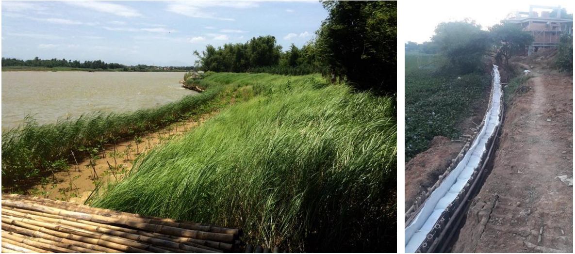
Hình 9. (Trên) Giải pháp kè mềm sinh thái đã giúp cho trang trại An Nhiên bảo vệ thành công bờ sông Thu Bồn trong mùa lũ. (Nguồn: Ngô Anh Đào); (Phải) Giải pháp thi công hạ tầng mềm không chỉ tạo ra môi trường sinh thái thân thiện mà còn góp phần phát triển bền vững cảnh quan ven mặt nước tại dự án Làng Mít (Nguồn: MeinGarten, 2019)
